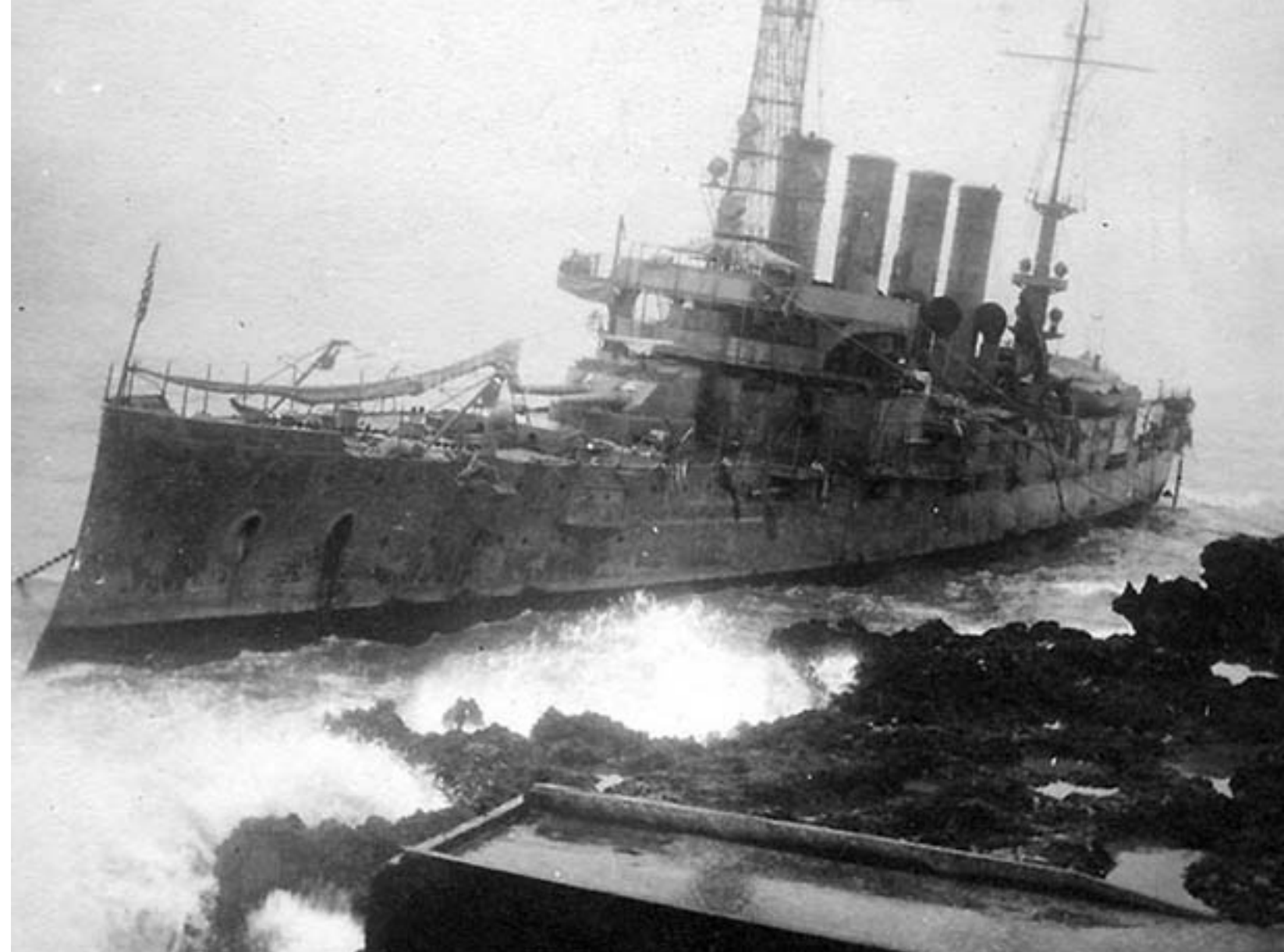
El Memphis sobre los acantarillados del "Placer de los Estudios".
