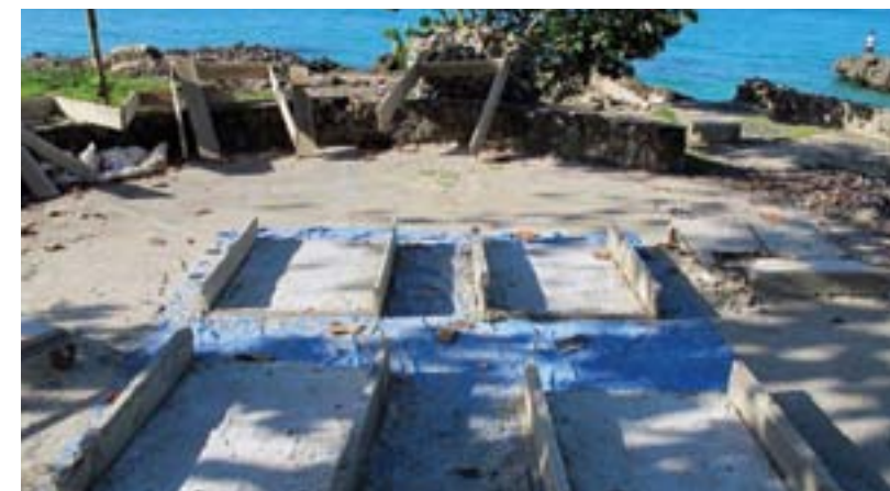
Casitas en construcción.
